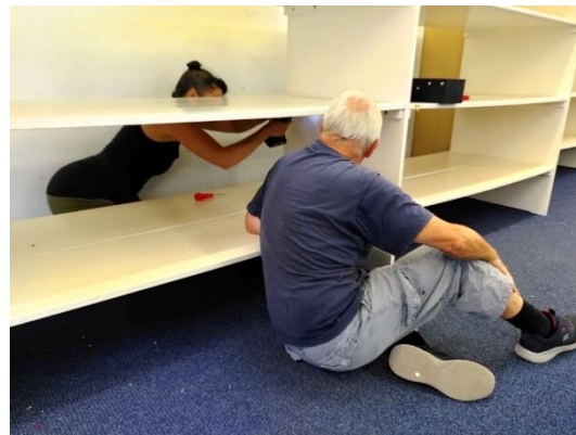
Demontage und Aufbau Regale
